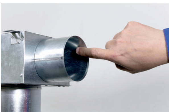
3) Vnitřní povrch vyústku namažeme kluzným přípravkem*.
