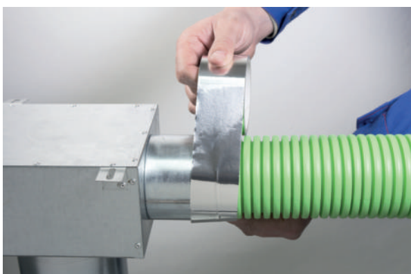
7) Spoj zajistíme vzduchotěsnou lepicí páskou.
